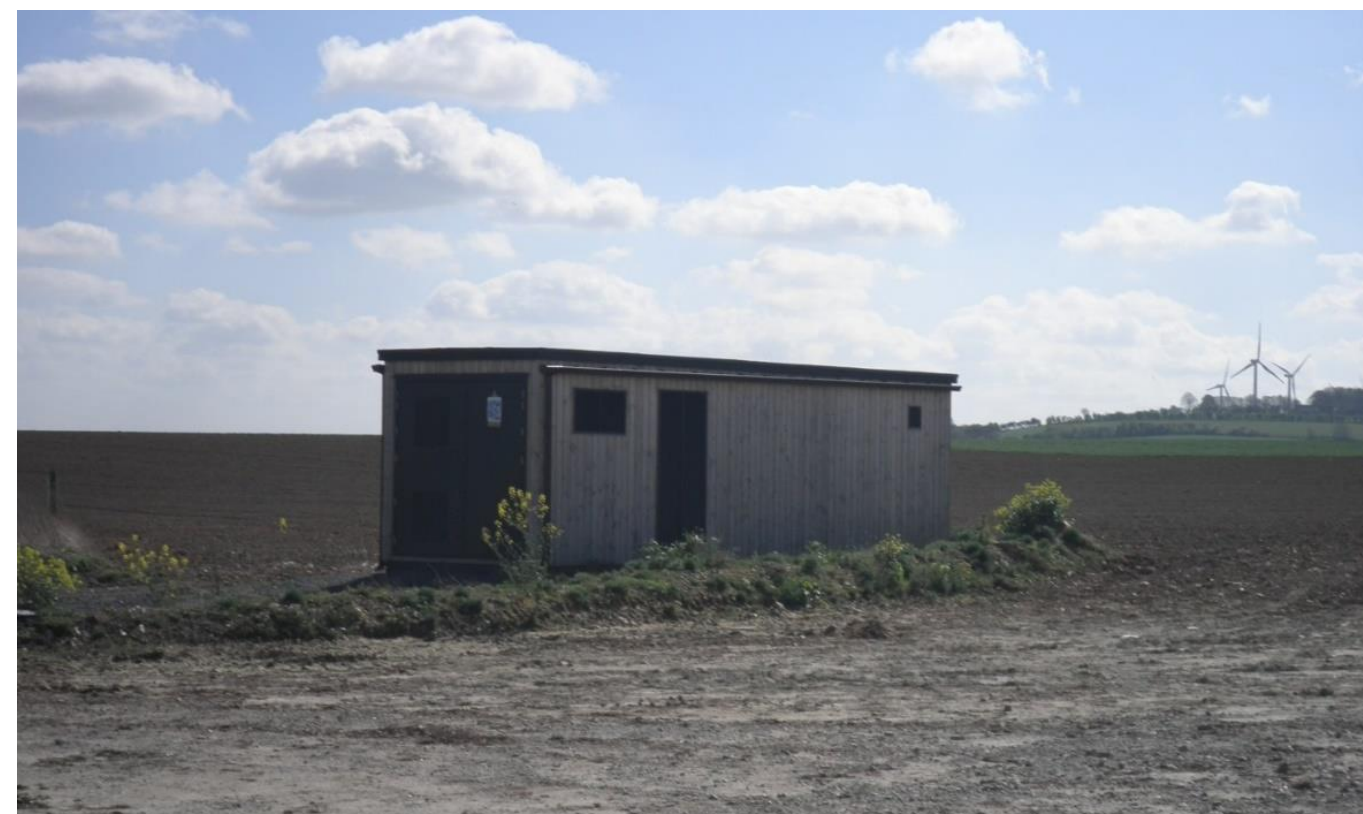
Illustration d'un poste de livraison (Source : Groupe VALECO)
