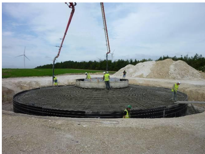
Construction d'une fondation
