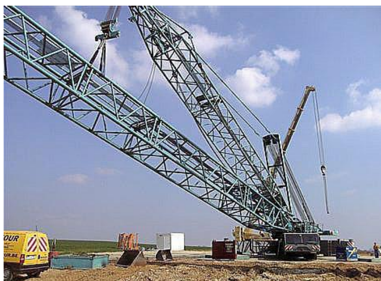
Grue de levage sur une plateforme
